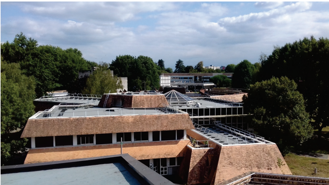
Toiture-terrace rénovée du bâtiment Droit-Économie-Gestion
