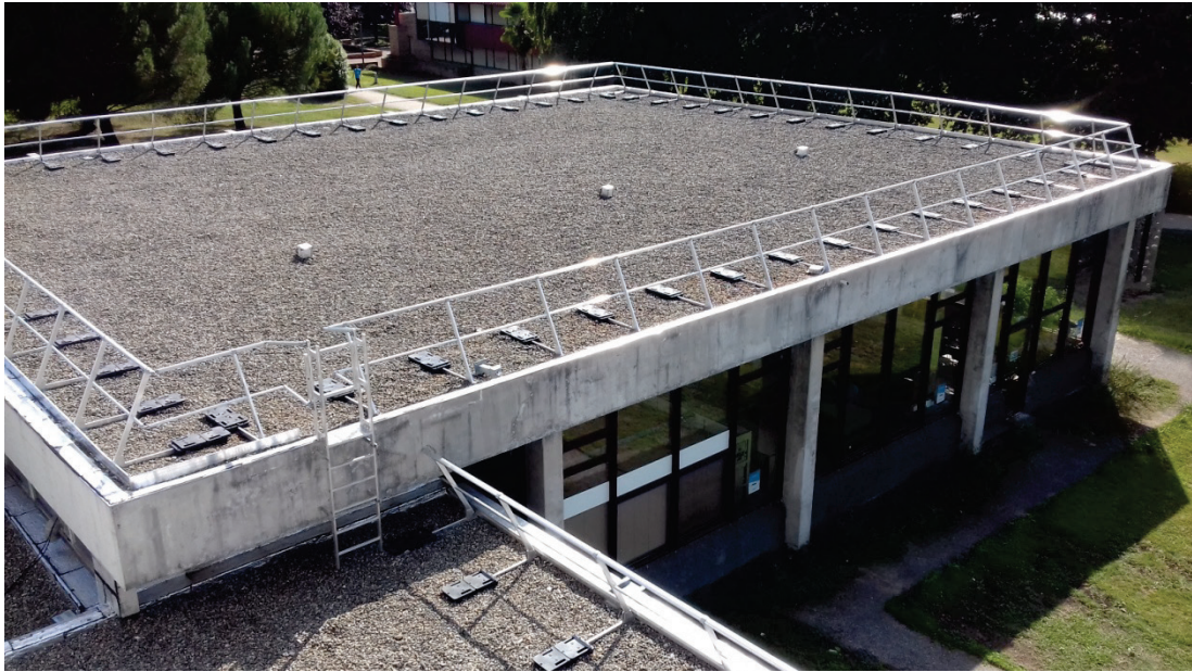
Toiture-terrace rénovée de la BU Sciences
